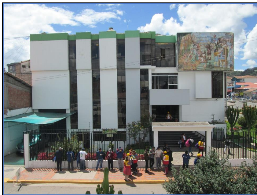
Foto: Vista frontal exterior del Edificio A
